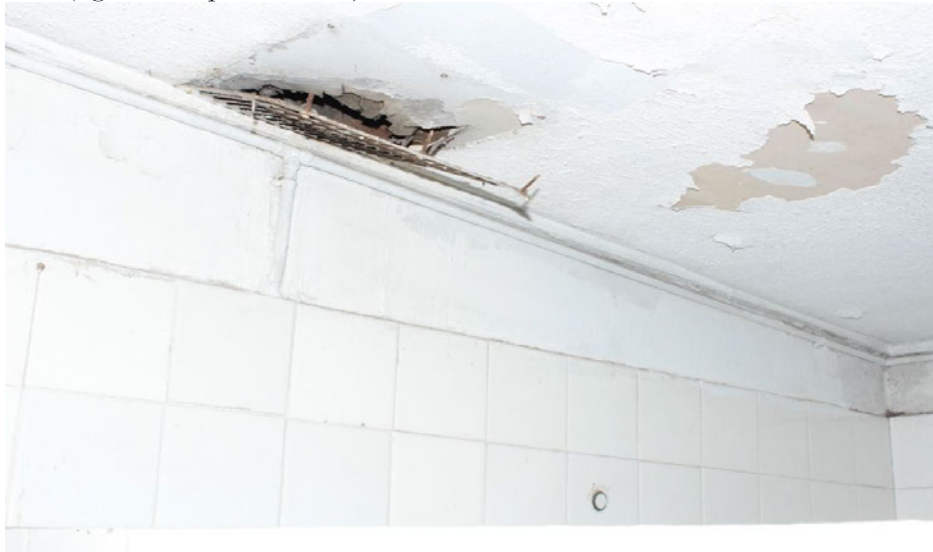
Fotografía N° 16 (segundo baño pabellón N° 1)
