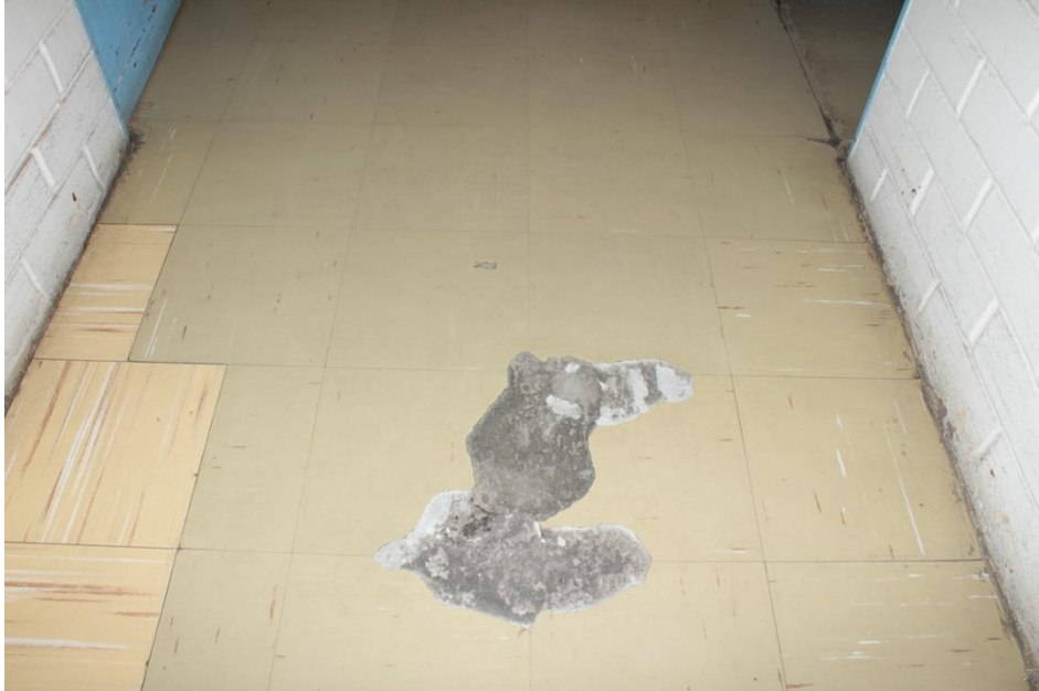
Fotografía N° 3 (Pasillo de pabellón N° 3)
