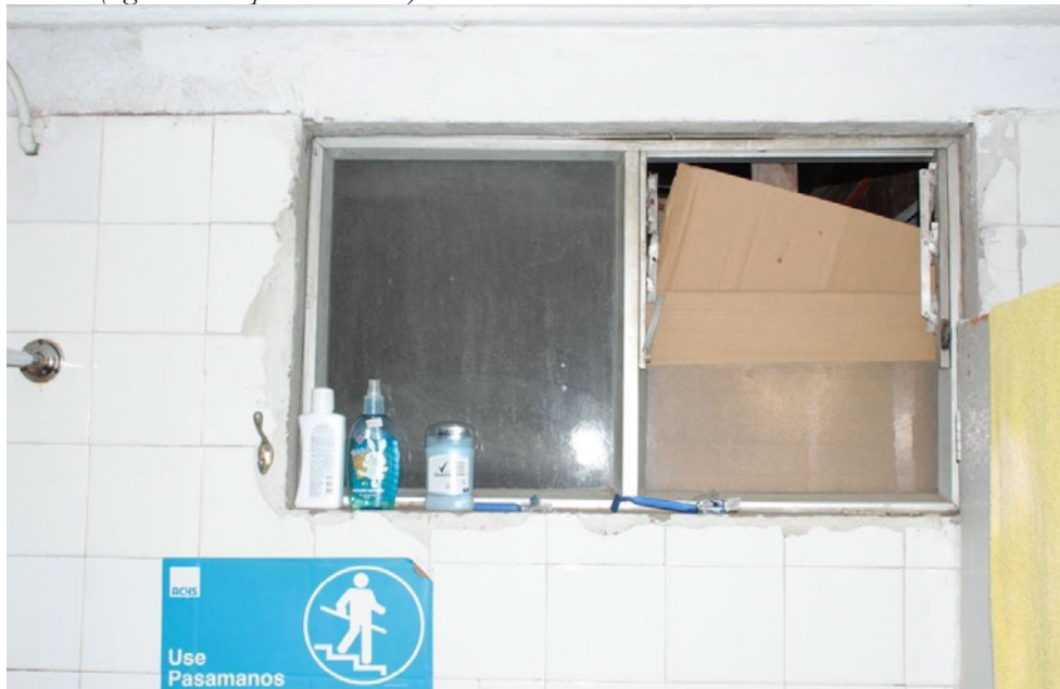
Fotografía N° 17 (segundo baño pabellón N° 1)
