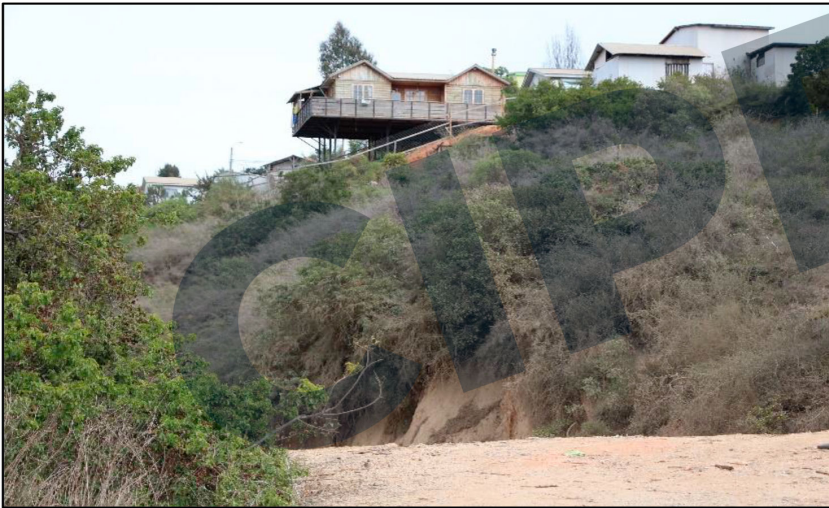
Imagen N°12: La Colina parte baja, sin construcción de cortafuegos.
