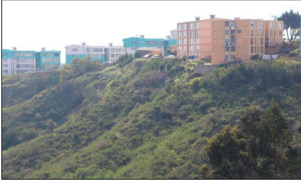
Imagen N°6: se debe realizar manejo de la vegetación perimetral a los blocks del sector.
