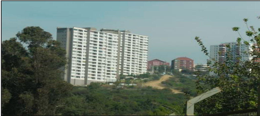
Imagen N° 29: Quebradas con vegetación muy cercana a viviendas.
