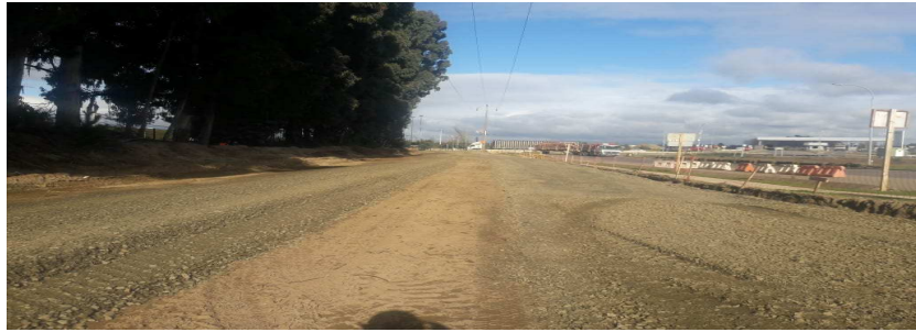
Ilustración 1-6 conformación de terraplenes y rellenos estructurales.
