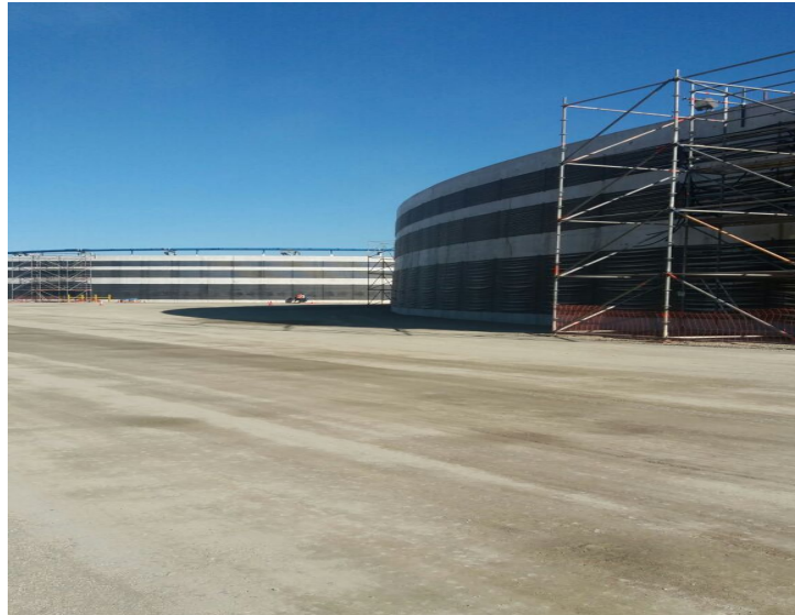
Ilustración 1-1 Reforzamiento de Bioreactores
