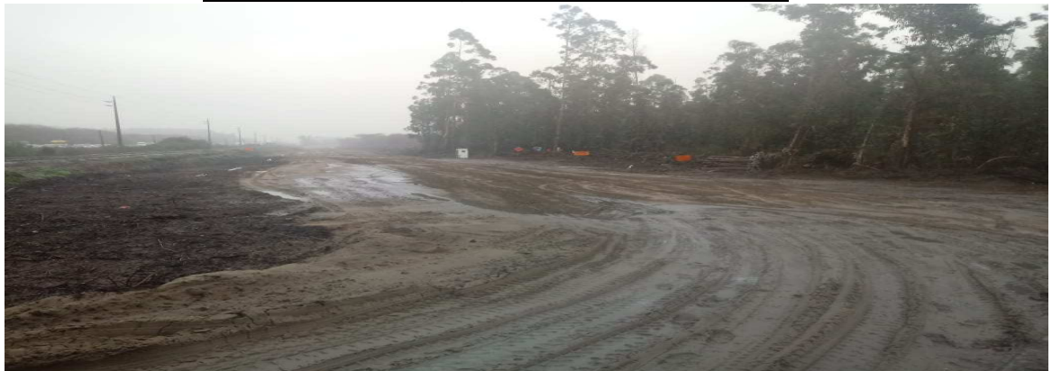
Ilustración 1-11 Rellenos y Conformación de Terraplenes.
