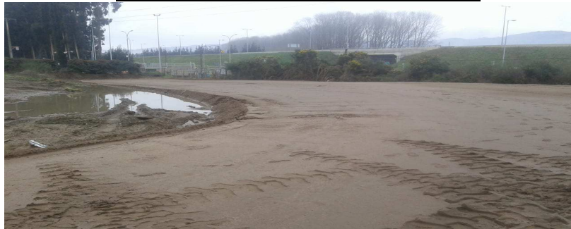
Ilustración 1-4 Conformación de Terraplenes.
