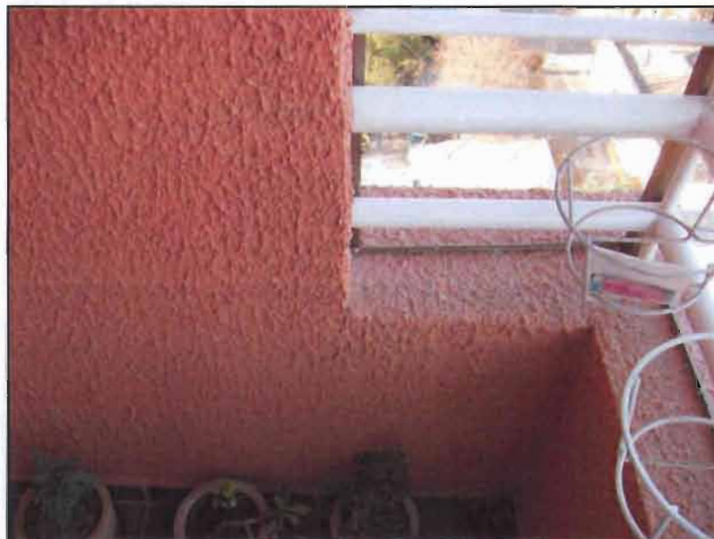
Fisura por corte de 0.7mm de espesor en viga de hormigón armado.
